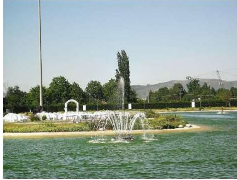
Bursa / Osmangazi Belediyesi Yüzen Fıskiye Sistemi
