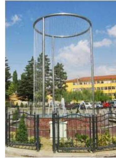
Ankara / Sarayköy Belediyesi Su Perdesi Fıskiye Sistemi
