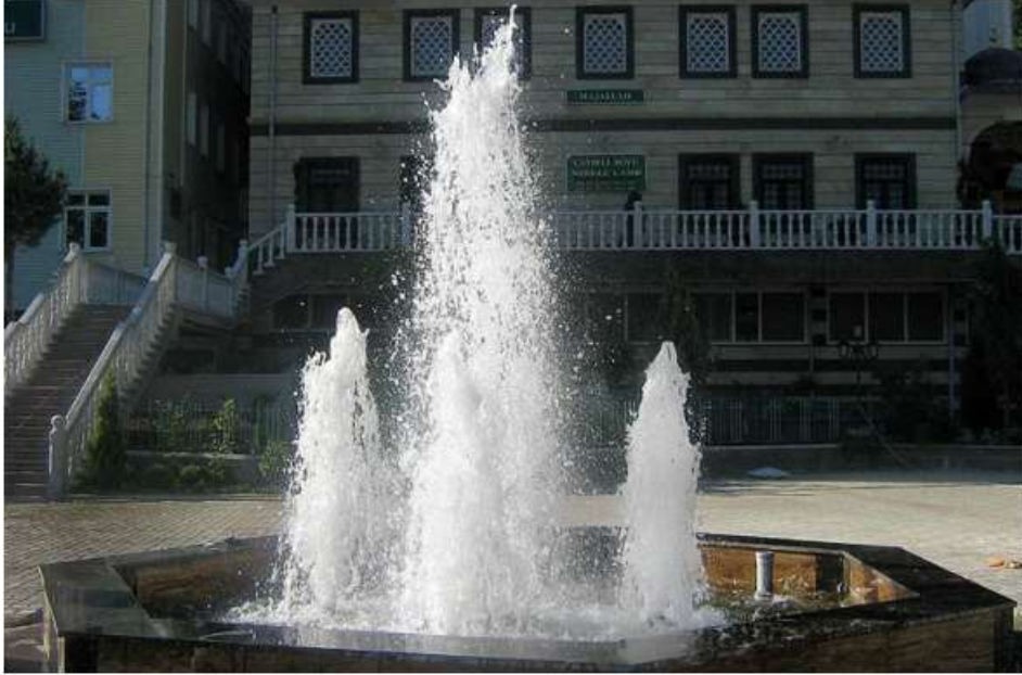
Rize Çayırılı Camii Köpük Fıskiye Sistemi
