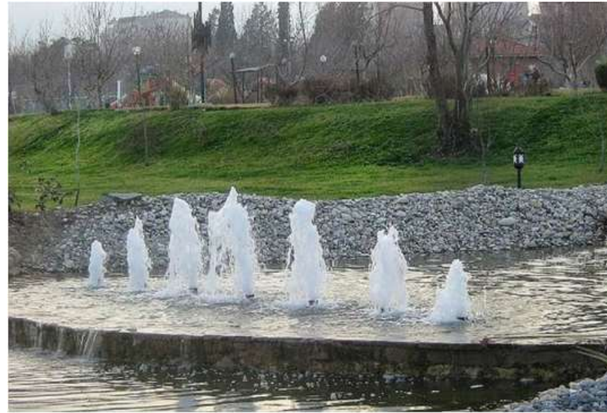
Denizli Büyükşehir Belediyesi Köpük Fıskiye Sistemi
