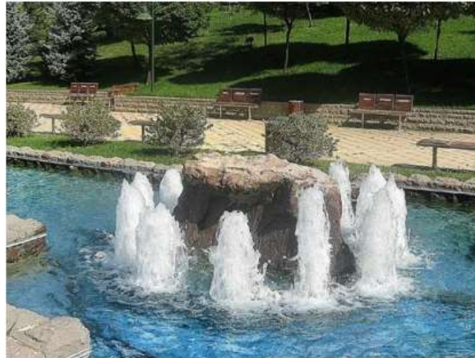
Ankara Dikmen Vadisi Köpük Fıskiye Sistemi
